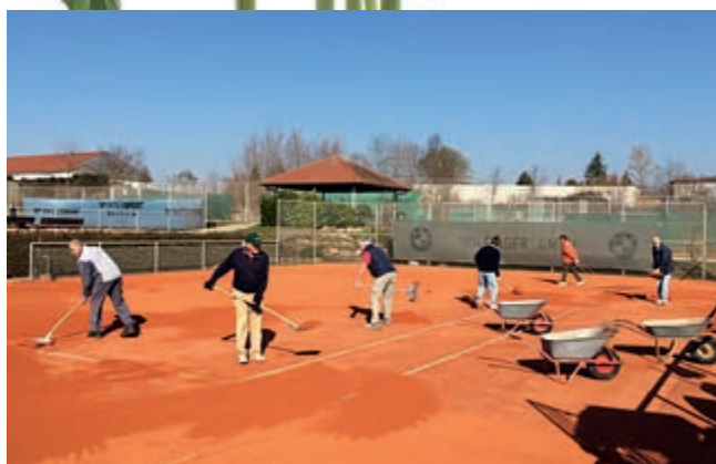
Instandsetzung der Plätze
